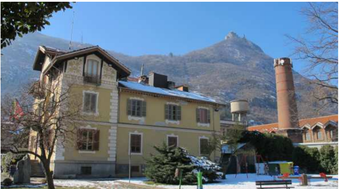
La sede del Comune di Sant'Ambrogio di Torino e la sua adiacenza con il manufatto dell'Ex Maglificio Bosio.
